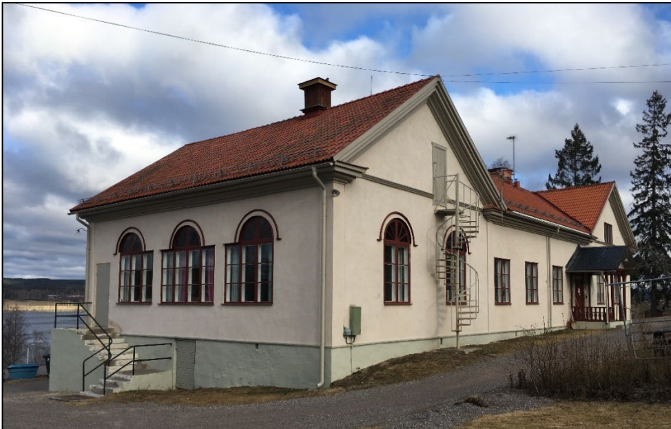
Ovan: Skolbyggnaden sedd från sydväst.
