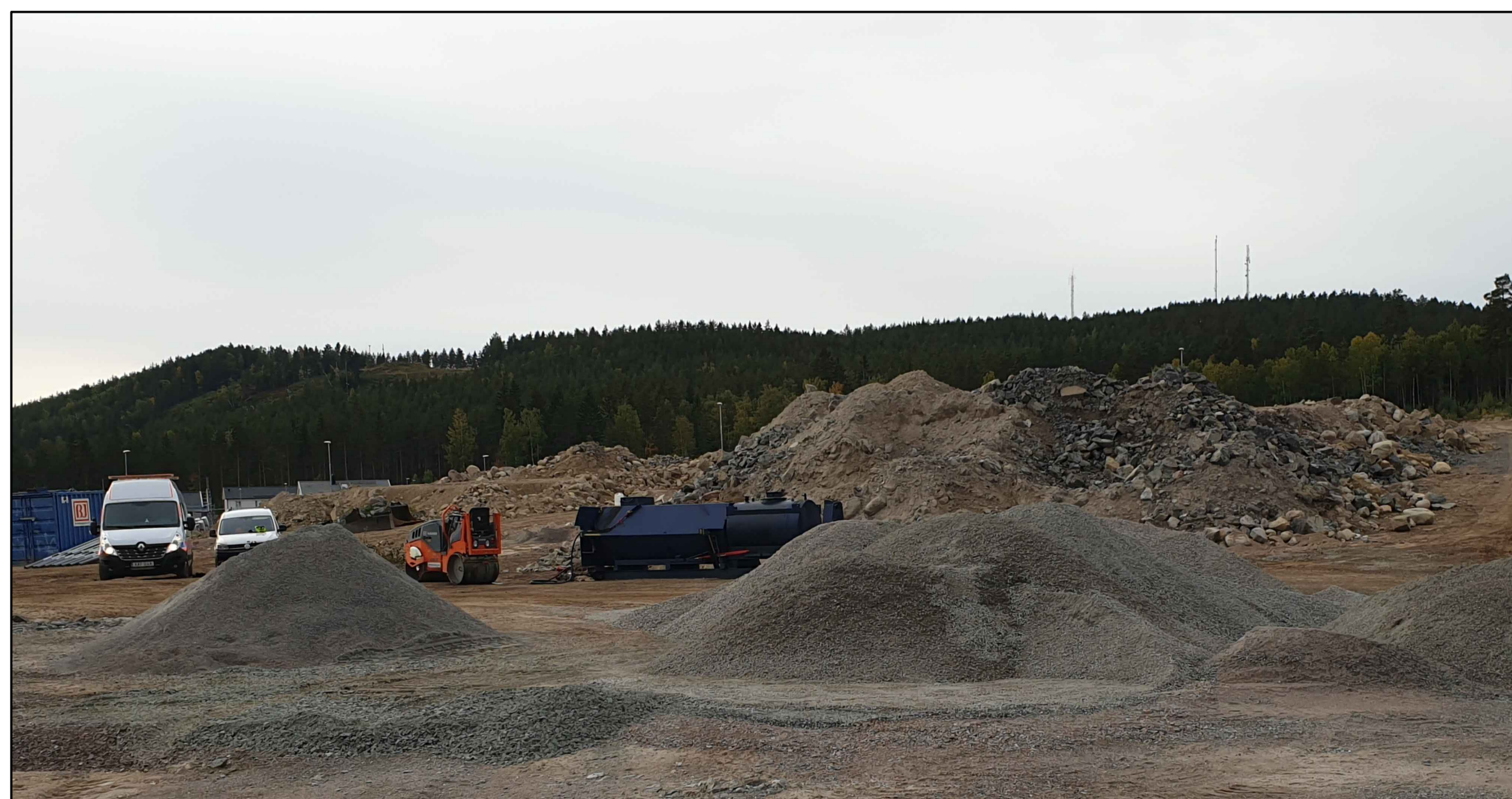
Bild över aktuell fastighet september 2020
